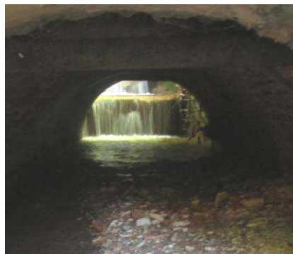
Vue 4 – Ruisseau des Vosges : pont Gambetta aval
