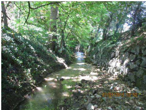
Vue 1 – Ruisseau des Vosges : enrochements
