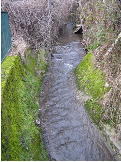
Vue 9 – Ruisseau des Vosges : Cunette aval
