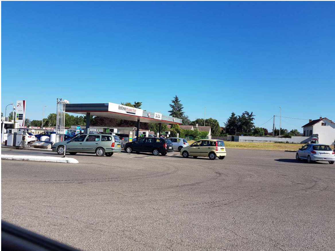
Station essence actuellement présente sur site
