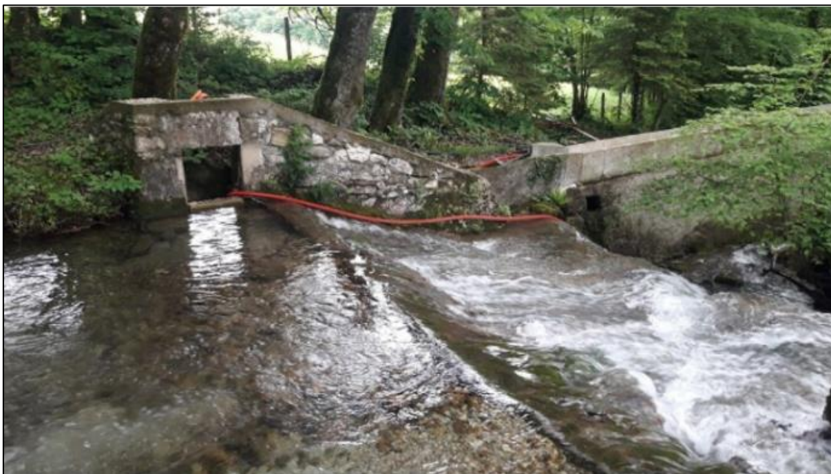
Prise de vue de l'ouvrage (source : GEOBS)
