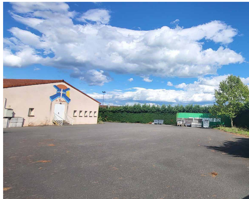
Surface en enrobé imperméabilisée autour du restaurant
