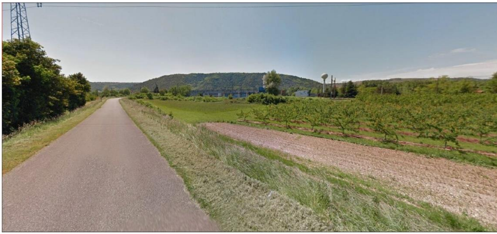
Figure 15 : situation lointaine du projet depuis la Rue des Marettes
