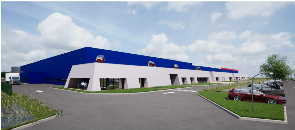
Figure 16 : Vue 3D du projet (Source : Notice Architecturale du bureau d'études Les Ateliers 4+)
