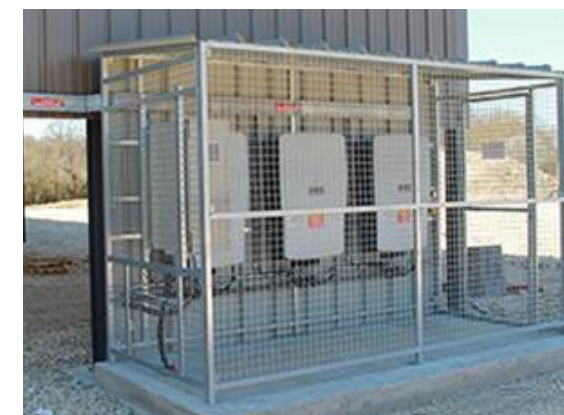
Exemple de poste onduleur grillagé
