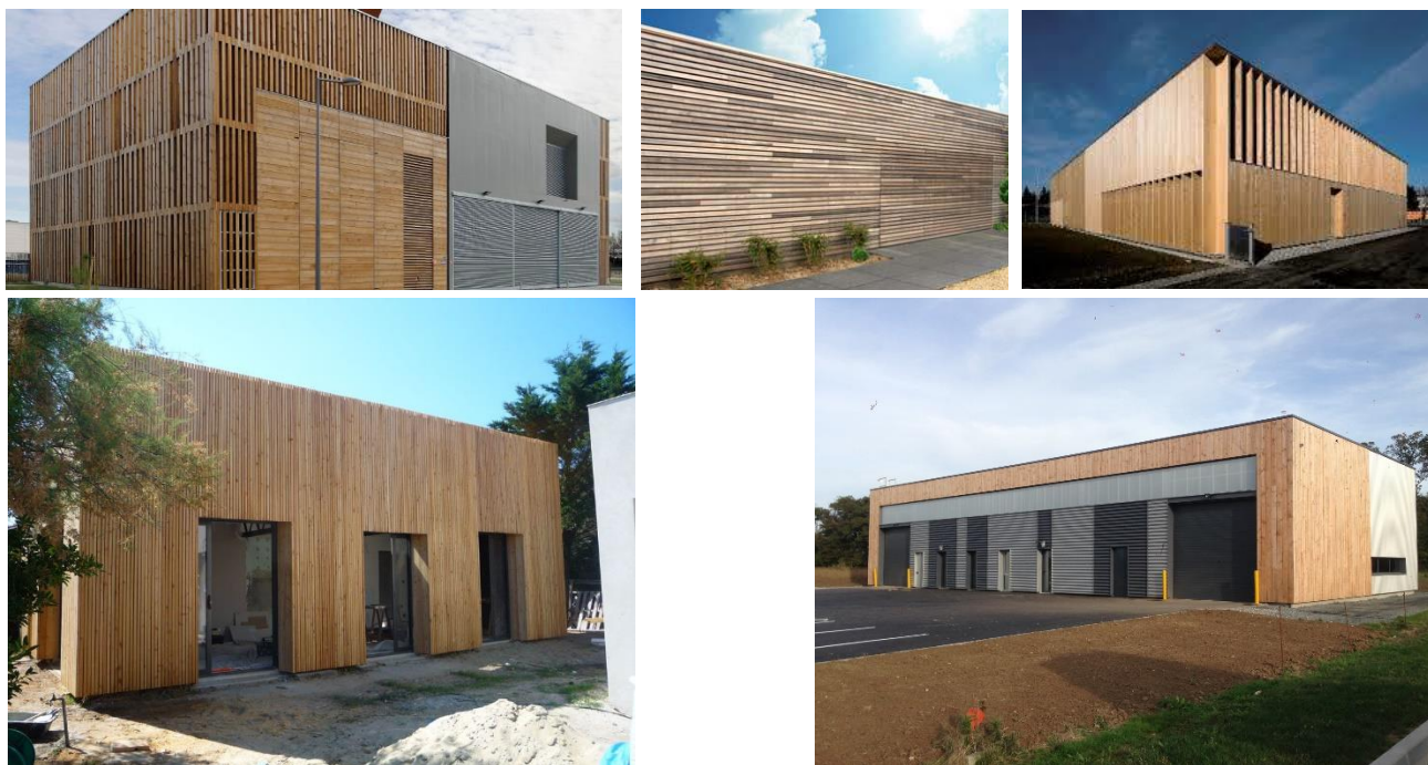
Traitement de façades des constructions
