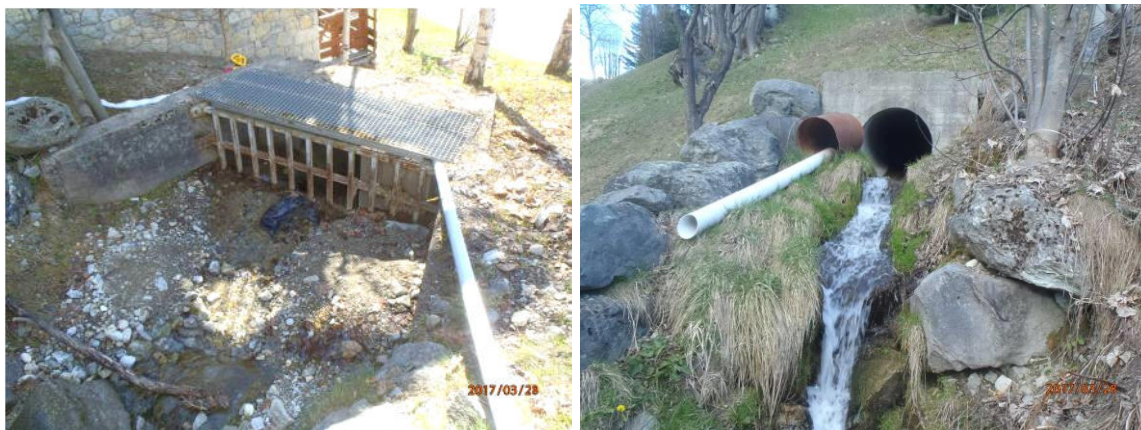
Figure 6 Tête et sortie de buse sous la route principale
