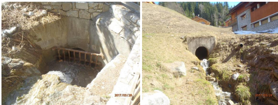
Figure 3 Le passage busé au droit de l'école
