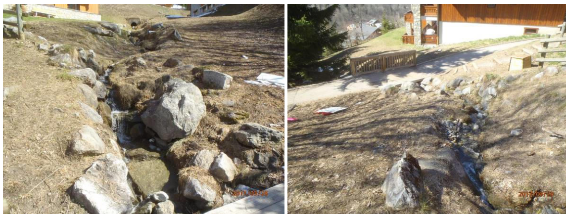
Figure 4 En amont de la passerelle, le lit et le faible tirant d'air sous la passerelle
