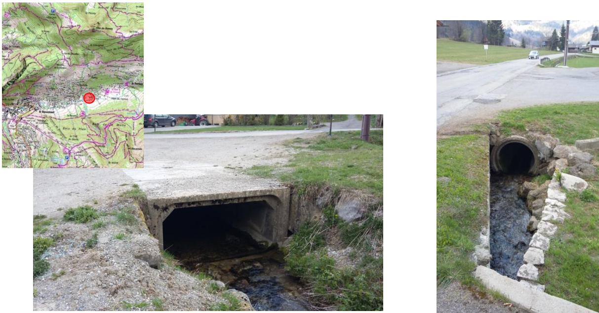
Figure 1 : Traversée de la route des Confins (Hydrétudes, 2017)
