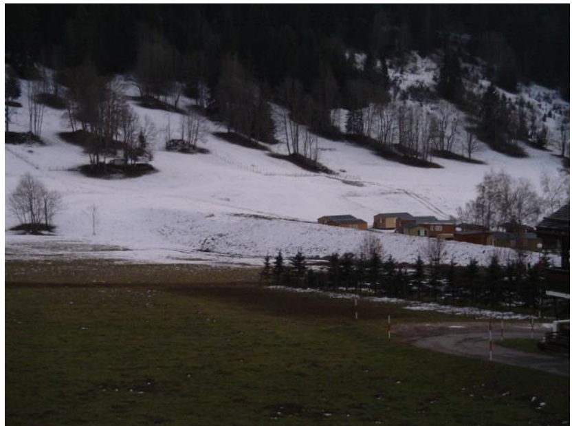
Figure 8 : Vue éloignée de la digue du Fernuy à remettre aux normes (Hydrétudes, 2004)
