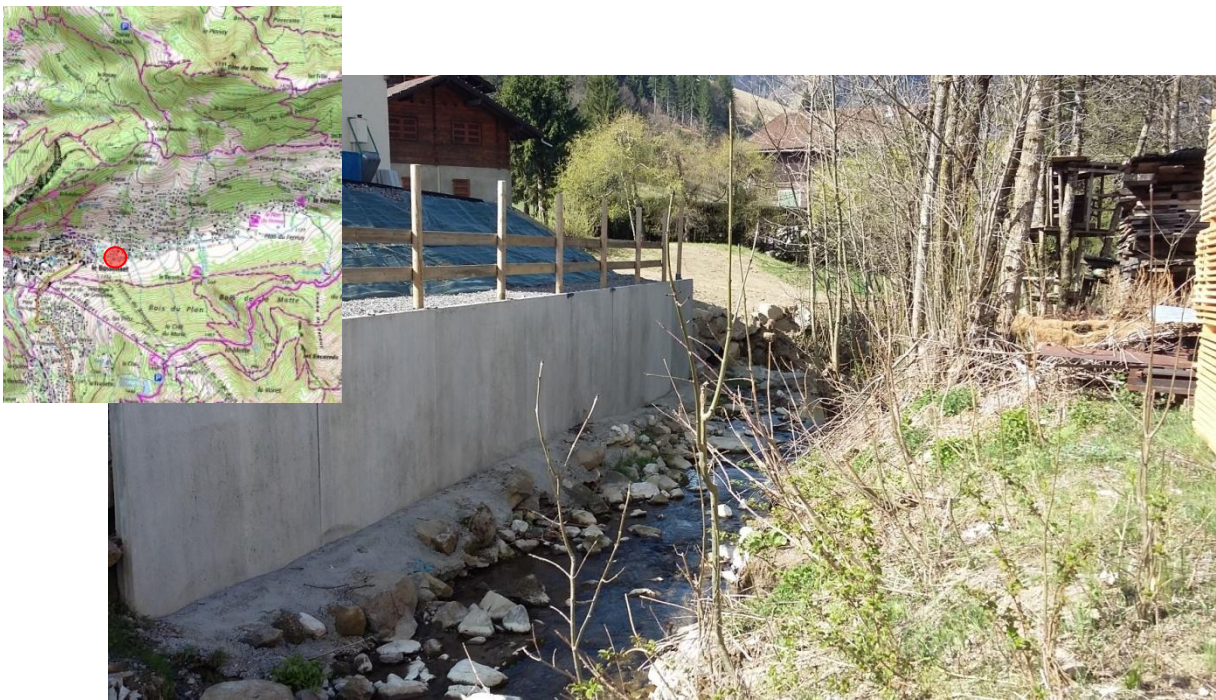
Figure 4 : Berge rive droite, au niveau de la scierie, à aménager par des enrochements et caissons végétalisés (Hydrétudes, 2017)
