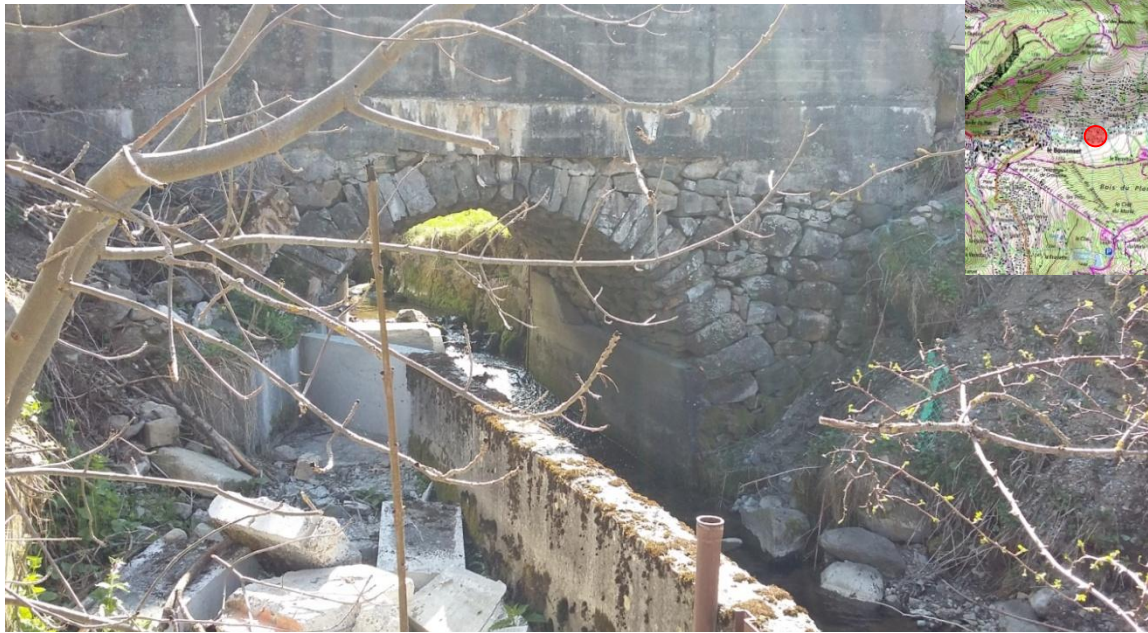
Figure 3 : Canal à l'amont de la scierie à supprimer (Hydrétudes, 2017)
