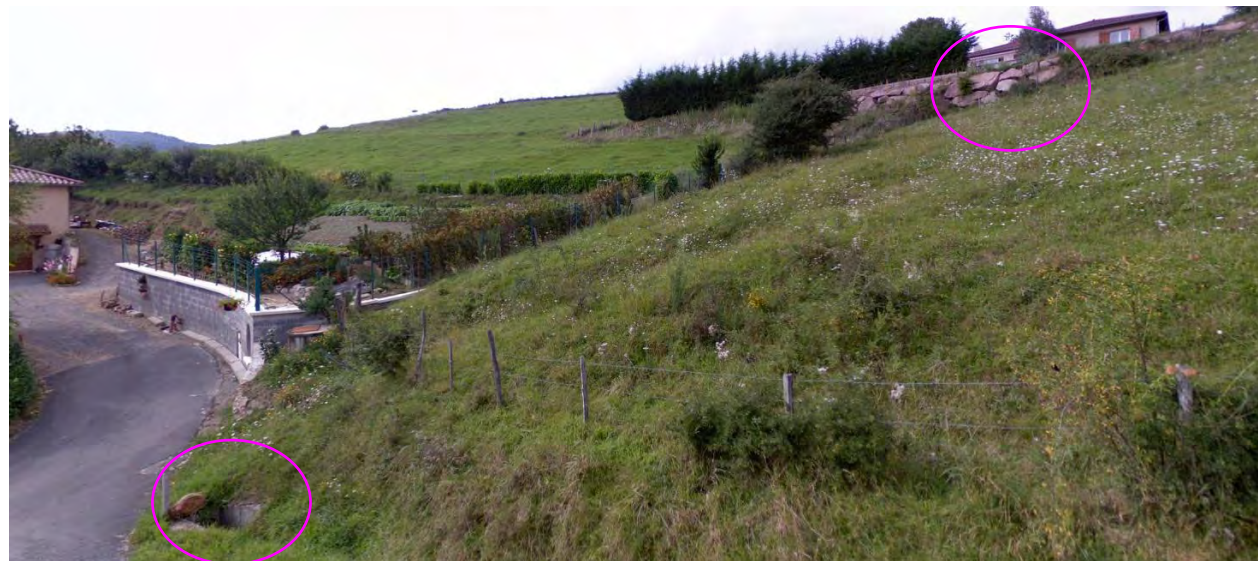
Déconnexion des Eaux pluviales de tête de réseau
