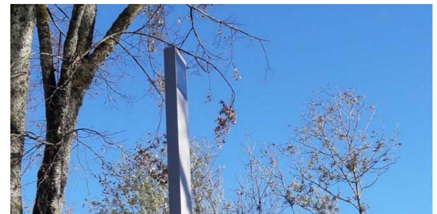
Les mâts d'éclairage
