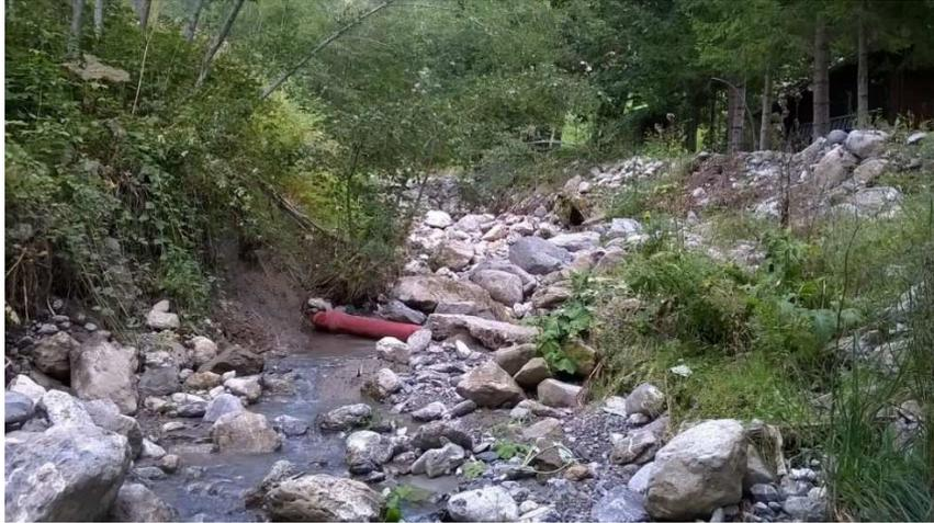
Figure 4 : Traversée réseau EU mise à nue en 2018 côté rive droite
