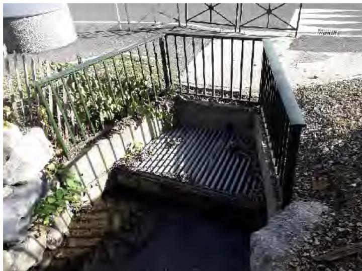
Figure 20 Bac de décantation protégeant passage sous voirie sur le Nant de Léchaud à Passy
