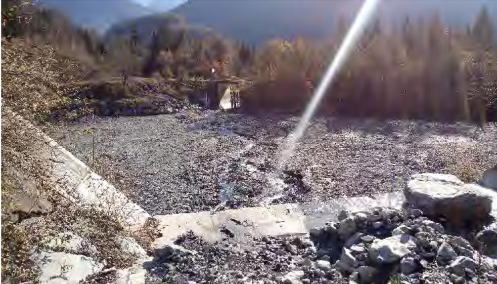
*Figure 19 Plage de dépôt avec ouvrage de fermeture sur le Nant Bordon*
