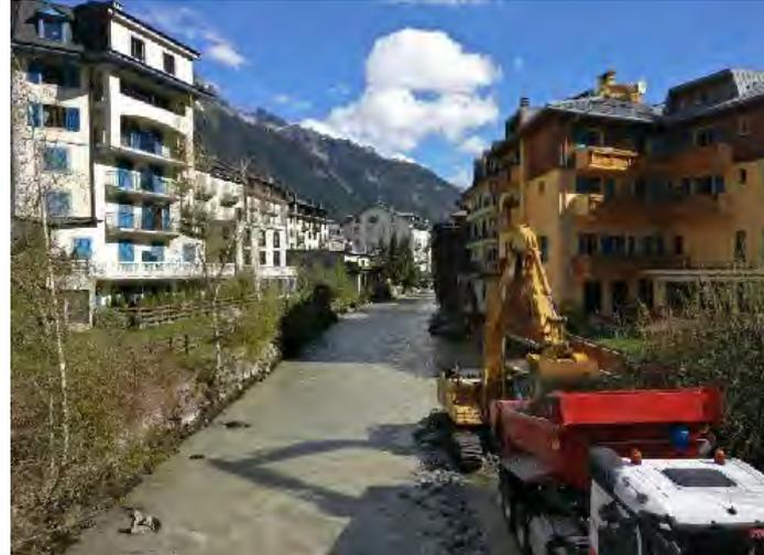
*Figure 106 Aménagement de piste sur demi-largeur de cours d'eau et chargement des matériaux lors d'un curage à Chamonix en 2019 (source: SM3A)*
