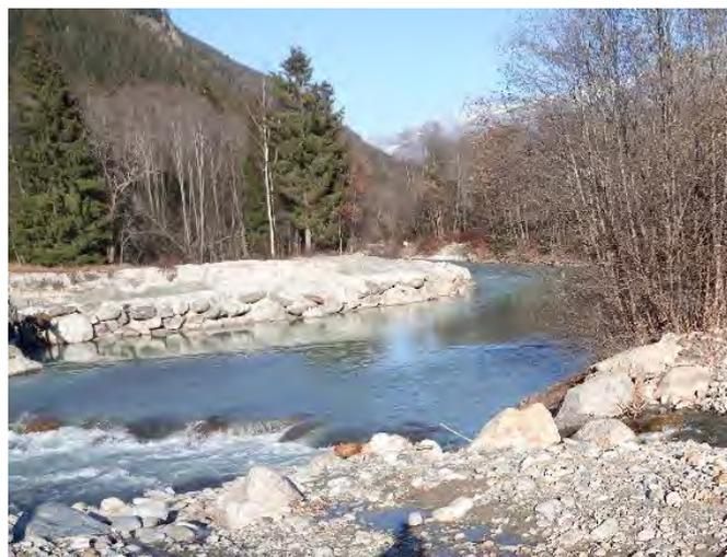
Figure 21 Bassin de sédimentation COTTARD sur l'Arveyron de la Mer de Glace (à g.), Seuil alimentant la prise d'eau du piège à matériaux VIALE en rive droite de l'Arve(à d.)
