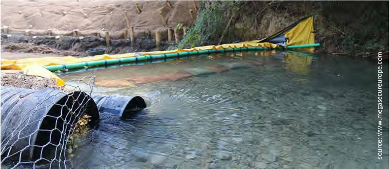
Figure 107 exemple d'entonnement de busage à l'aide de batardeau souple (source megasecur)
