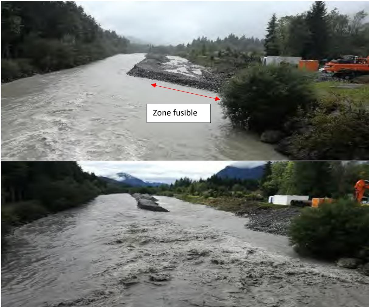
Figure 109 Sollicitation de la zone fusible (déversoir) d'un batardeau sur le Giffre
