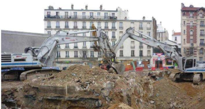
La déconstruction mécanique des semelles isolées est assurée par une pelle à chenilles équipée d'une pince à béton ou d'un godet. La pelle enlève tout d'abord la terre présente autour du massif de fondation puis arrache le massif à l'aide de son godet ou d'une dent de déroctage.
