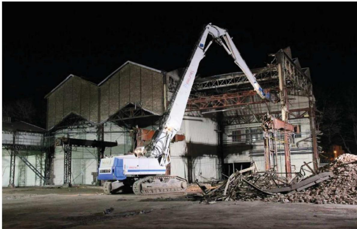
La démolition commence par la dépose du bardage métallique avec la pelle équipée du grappin. Celle-ci en lève le bardage horizontal et vertical ainsi que l'isolant. Elle trie au passage les déchets.
