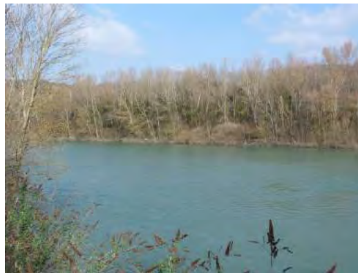
Vue sud-est du canal écreteur Source : Ecosphère
