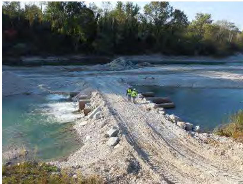
Figure 3 : Travaux de désengrèvement du Vieux Rhône (BURGEAP, sept. 2015)
