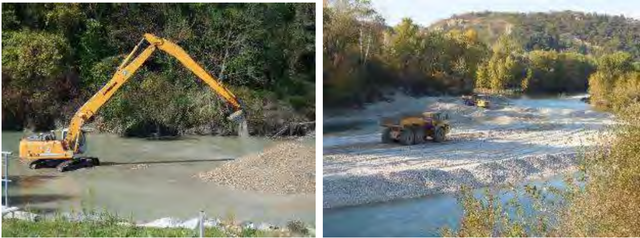
Figure 8 : Engins de chantier – pelle à long bras et camions/dumpers (BURGEAP, septembre 2015)
