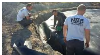
Création de 4 mares : creusement et mise en place de l'étanchéité, Ecostratégie
