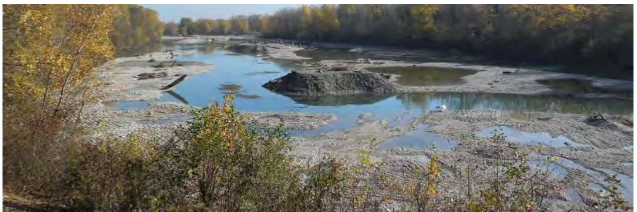
Canal écreteur aménagé – Novembre 2016- Débit réservé 30m 3 /s –QRhône= 190m 3 /s, Ecosphère
