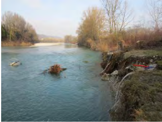
Berge du Vieux Rhône érodée et station et bras de la station d'alerte emportée (12 janvier 2012) Source : Burgeap
