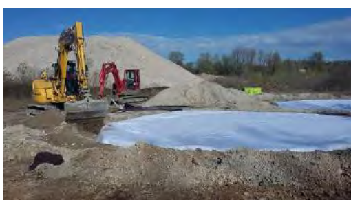
Création de 4 mares : creusement et mise en place de l'étanchéité, Ecostratégie
