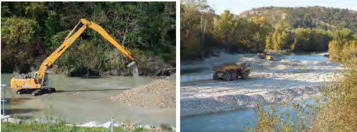
Figure 6 : Engins de chantier – pelle à long bras et camions/dumpers (BURGEAP, septembre 2015)
