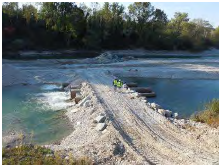
Figure 5 : Travaux de désengrèvement du Vieux Rhône (BURGEAP, sept. 2015)
