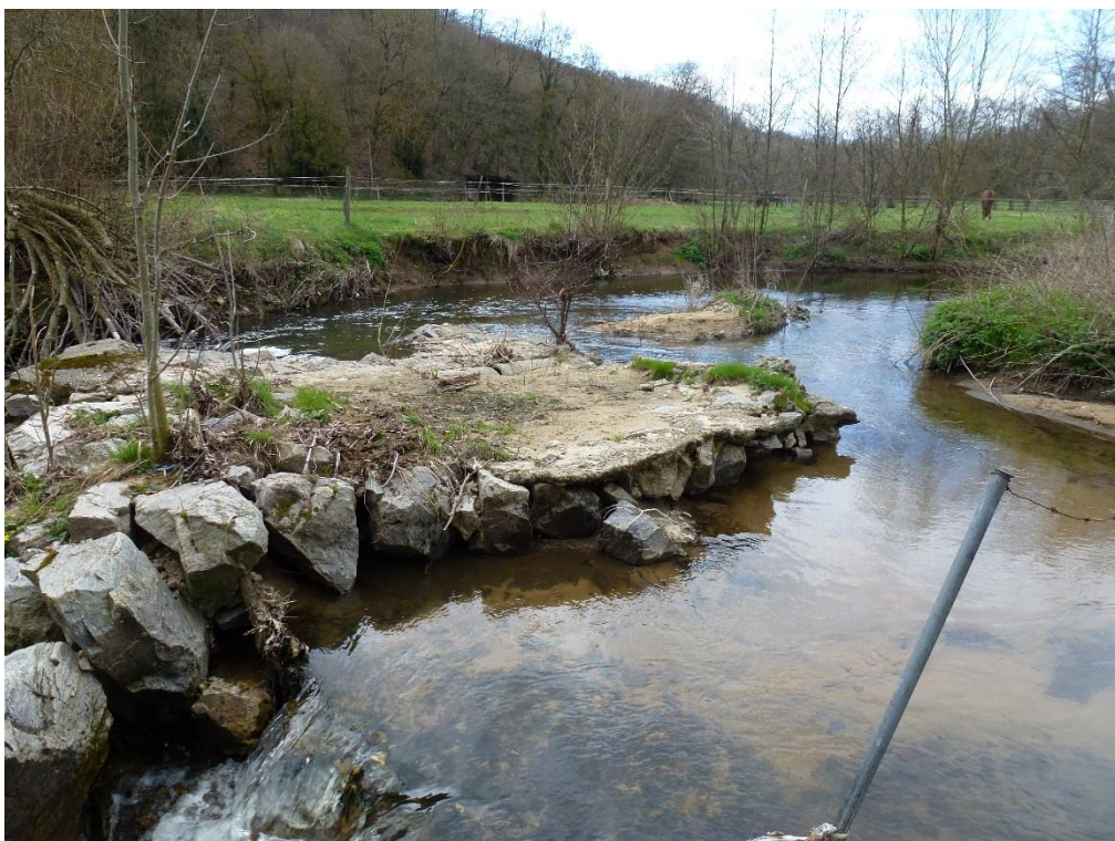
3 – Vue de l'environnement à l'amont du seuil
