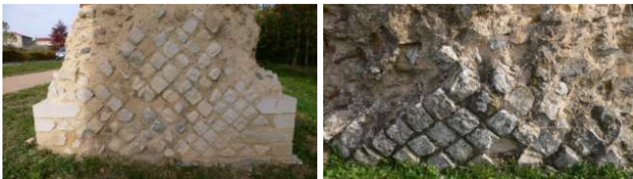
Figure 8 : Exemple de restauration de pile romaine, à Chaponost.
