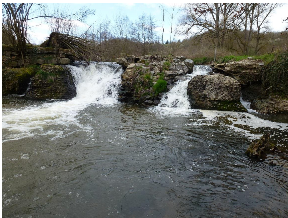
1 – Vue du seuil (depuis l'amont)
