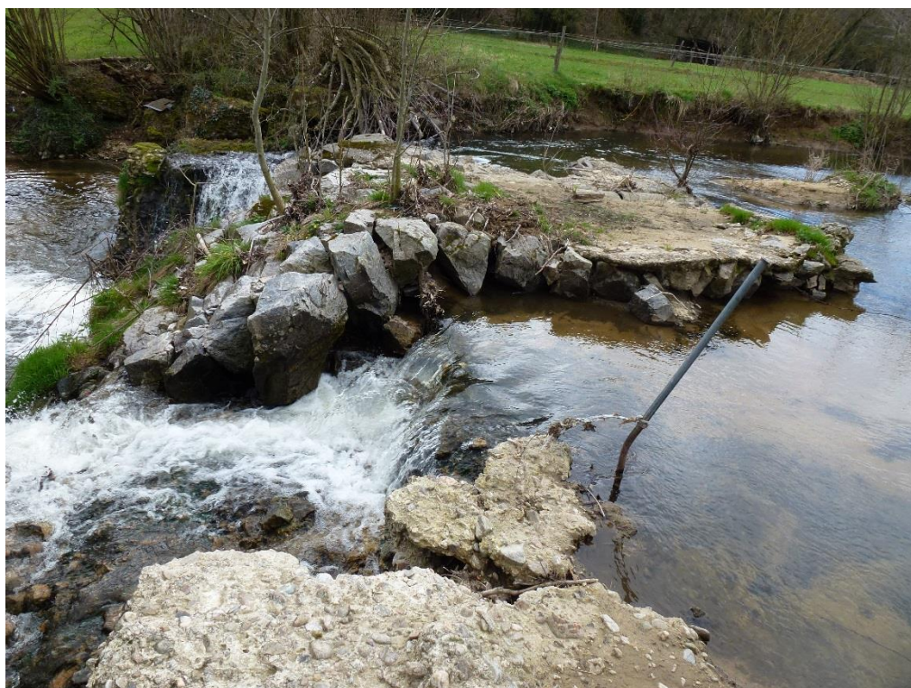
2- Vue de la partie haute du seuil
