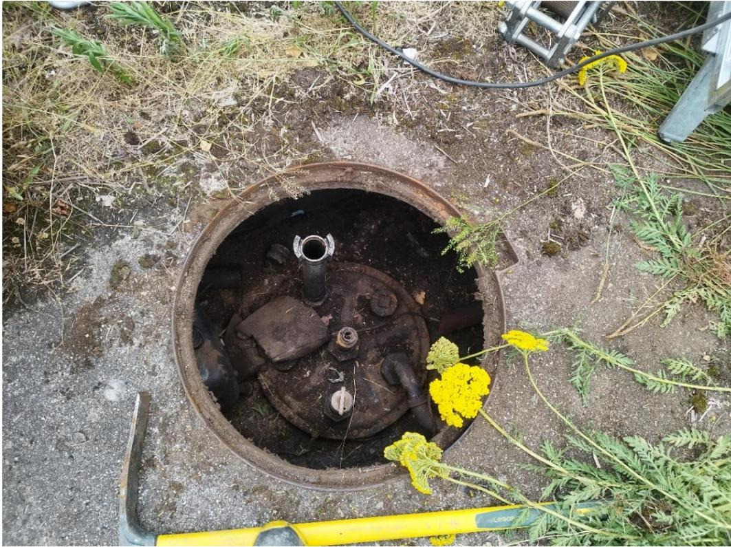
Figure 5 : Tampon de la cuve à huiles usagées enterrée
