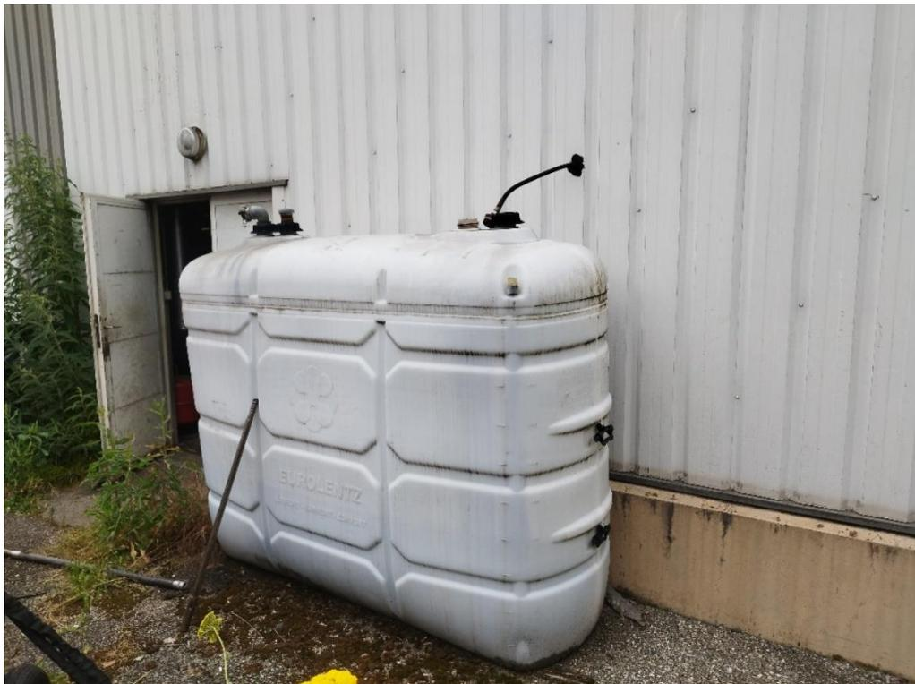
Figure 6 : Nouvelle cuve à huiles usagées aérienne
