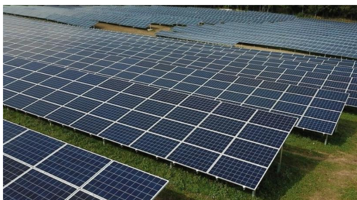
Figure 6 : Exemple de table photovoltaïque sur pieux en 4H
