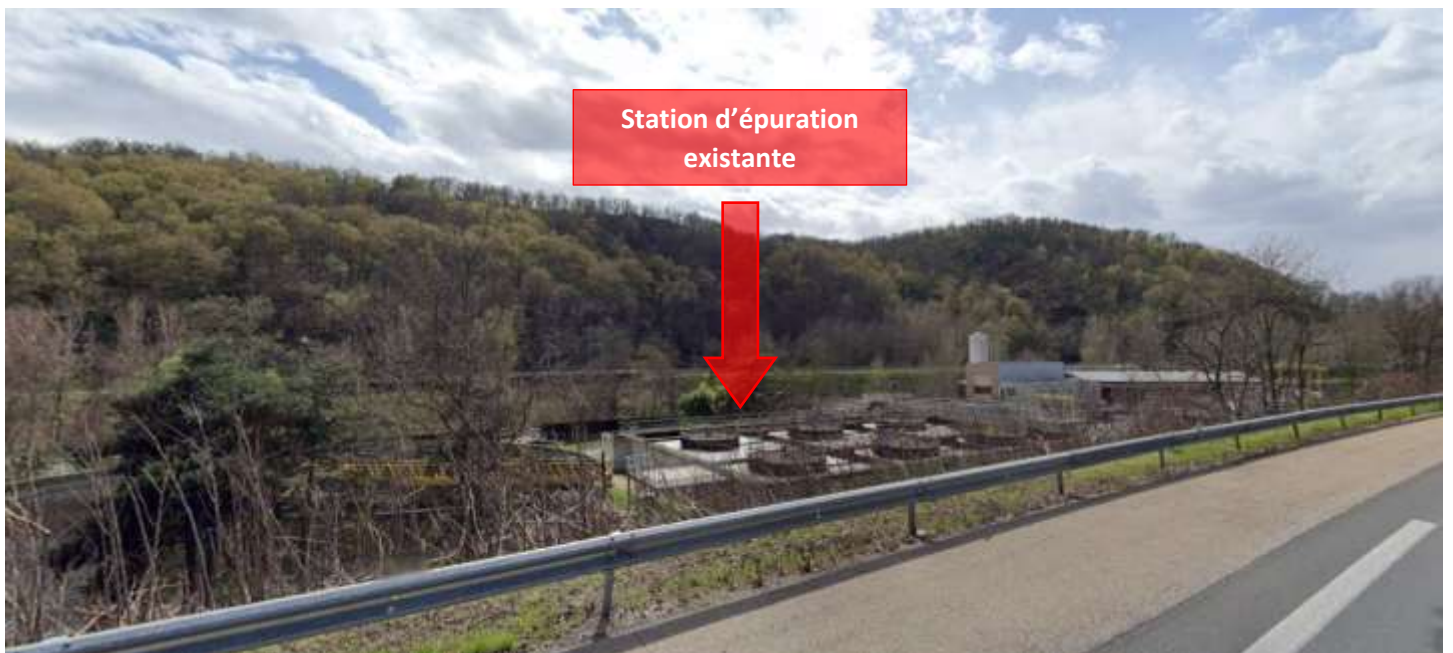
2. Site de la station d'épuration existante vu depuis l'Autoroute A72 (prise de vue mars 2023)
