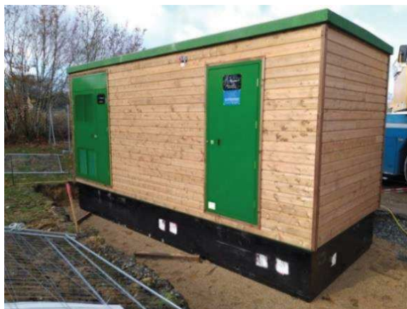
Figure 3 : Poste de livraison prévu pour ce type de projet
