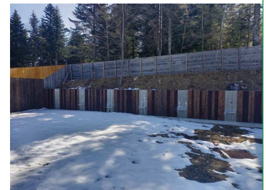
Ci-dessous : pas de tir de 10 m à la Chavade (07)
