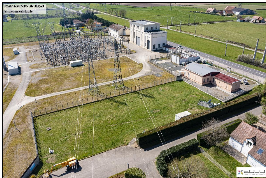
Figure 9 : Poste de Bayet vu du ciel - Situation existante (Source : 3dvision)
