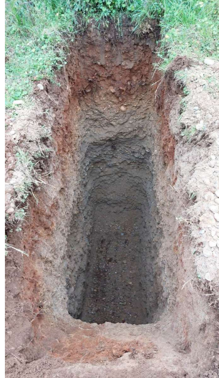
Vue du fond de fouille
