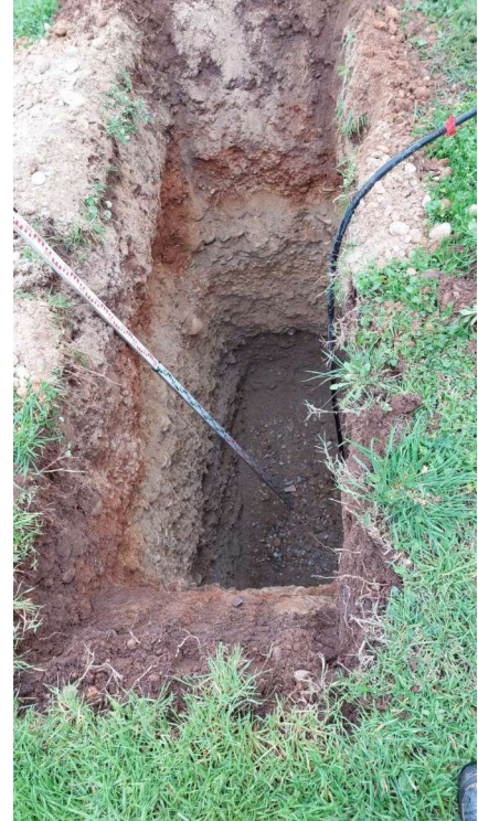
Vue du fond de fouille
