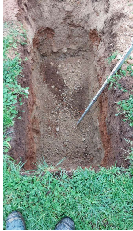
Vue du fond de fouille
