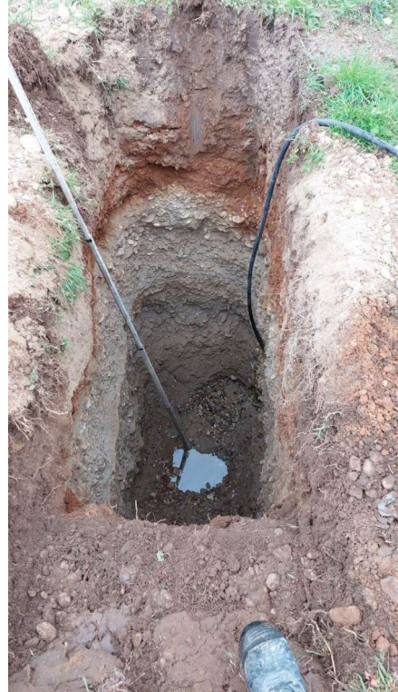
Vue du fond de fouille
