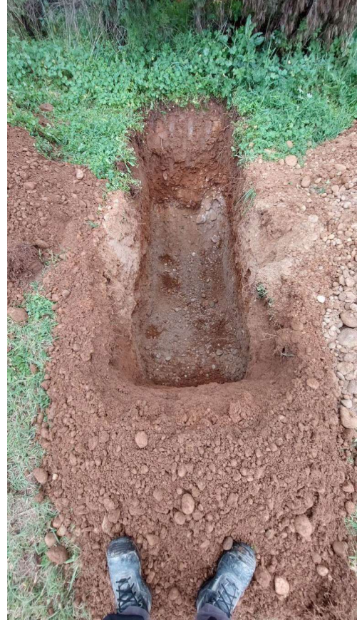
Vue du fond de fouille
