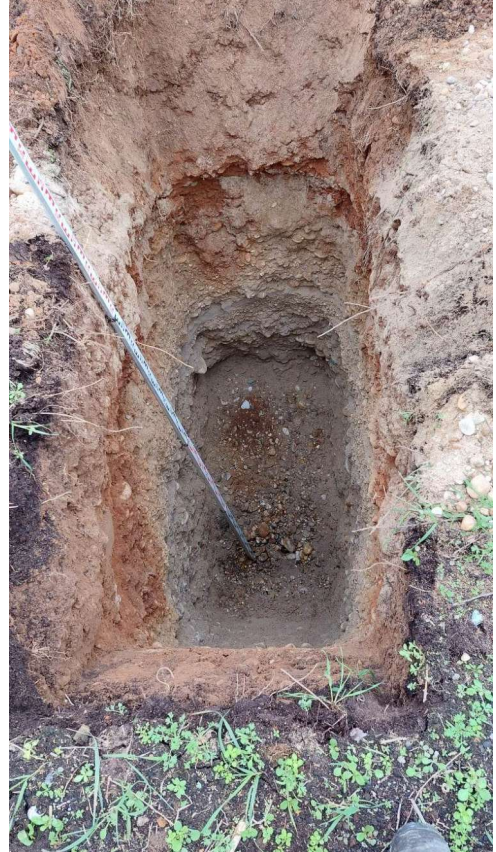
Vue du fond de fouille
