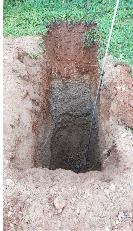
Vue du fond de fouille
