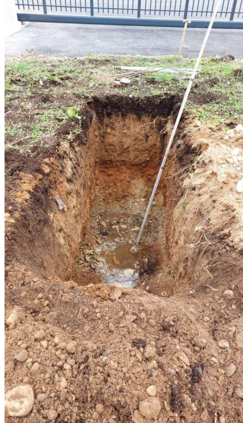
Vue du fond de fouille
