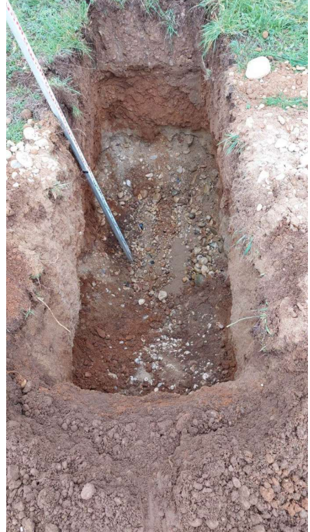
Vue du fond de fouille
