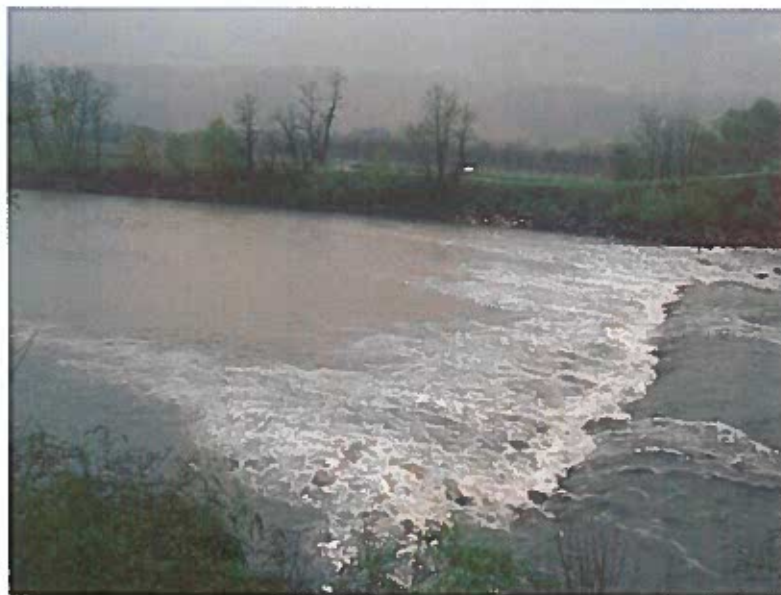
Figure 2: Vue de la partie aval à partir de la rive gauche du seuil de la Buisnière (08/04/2014)
