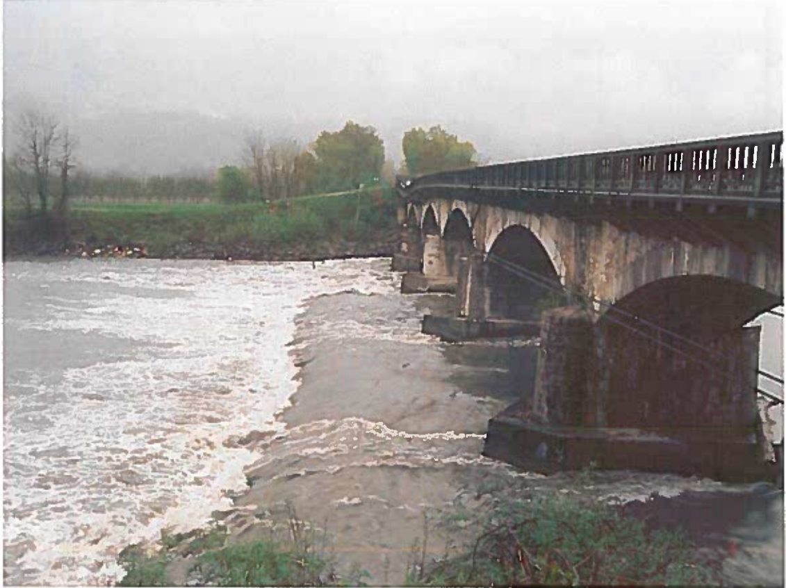
Figure 1: Vue depuis la rive gauche du seuil de la Buisnière (08/04/2014)
