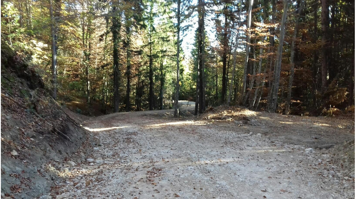
Exemple de route forestière empiercée. La largeur de l'emprise est la même que l'assiette des terrassements
