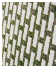
Pavage en béton avec ouvertures de drainage
