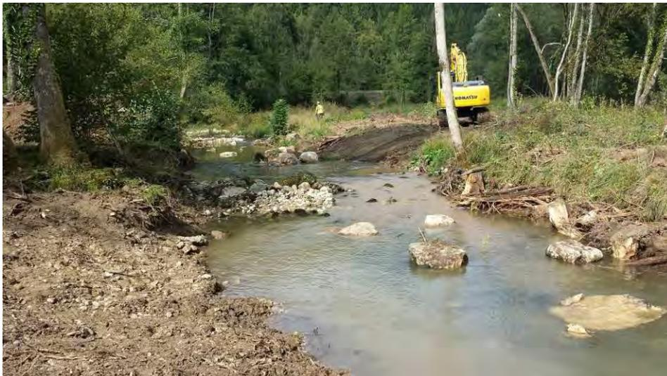
Figure 48: Diversification du lit mineur (épis, blocs et souches en pied de berge) sur le Lange à Martignat (01)
