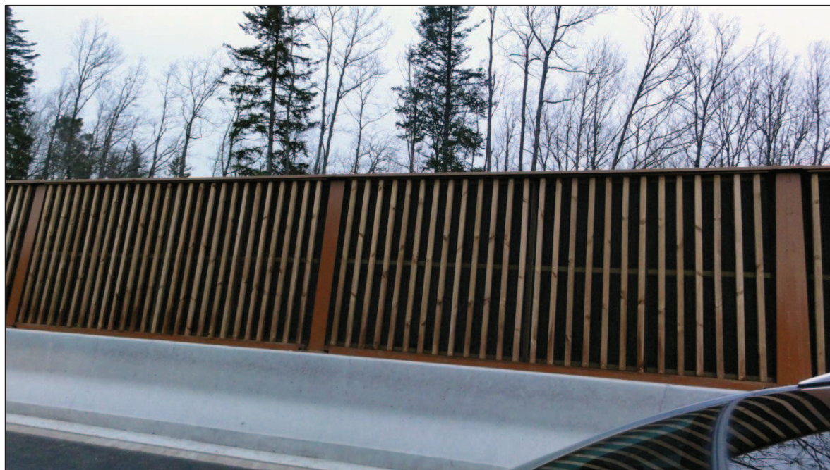
Photo 74 : Écran acoustique issu de la ligne architecturale implantée sur l'A89. Source : © Egis environnement
