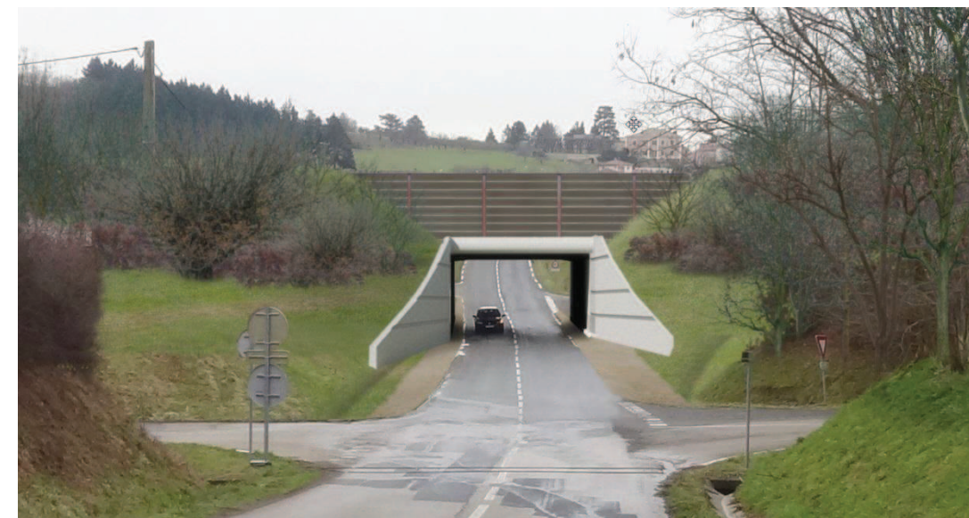
Photo 70 : Photomontage depuis le nord de la RD73 de l'implantation d'un écran acoustique sur le passage inférieur de la RD73 (situation avant et après projet, point de vue V3 sur la carte de synthèse des mesures)
