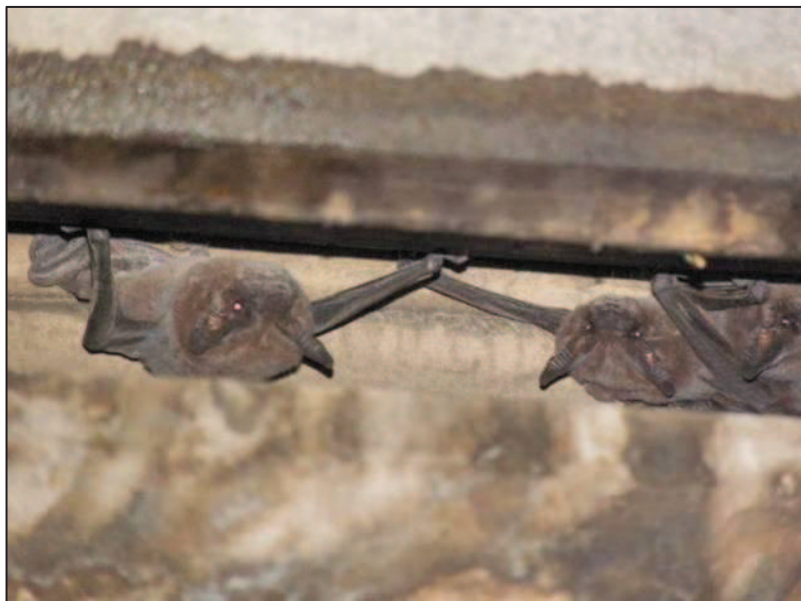
Photo 75 : Chiroptères dans gîte diurne, joint entre deux éléments préfabriqués d'un ouvrage hydraulique cadre
