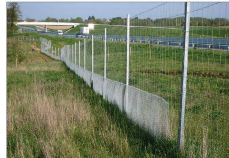
**Photo 68 : Illustration d'une clôture faune doublée d'une clôture imperméable aux amphibiens (sans bavolet)**
