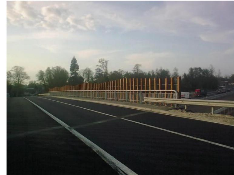
**Photo 67 : Exemples de mise en œuvre de palissades sur un ouvrage supérieur existant sur l'A63 pour favoriser le franchissement des Chiroptères.**
