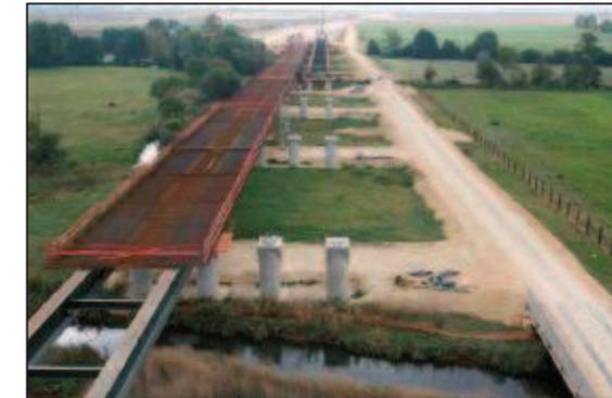
Photo 63 : Exemple de piste pour la construction d'un viaduc (vallée de l'Orne, A88).
