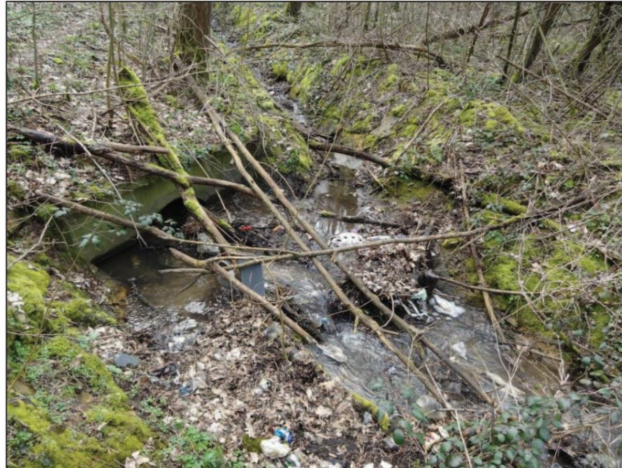
Photo 65 : Un point de rejet des eaux de plate-forme de la RN489 au droit du Bois des Longes
