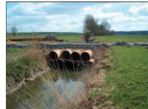
Photo 64 : Exemple de franchissement provisoire sur un cours d'eau.
