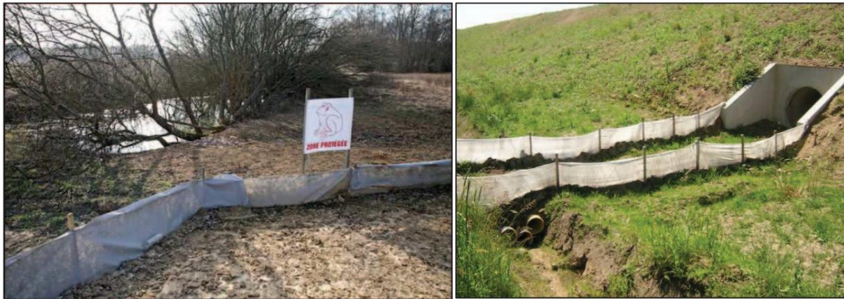
**Photo 66 : Exemples d'implantations de clôtures anti-intrusion vis-à-vis des amphibiens sur des projets d'infrastructures**
