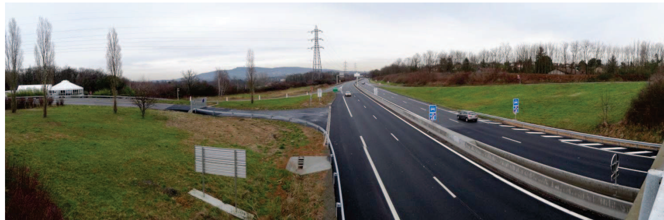
Photo 47 : S1-12 - Vue depuis le passage supérieur de la RD30. Source : © Egis Environnement / O. GAUDIN, 2013.
