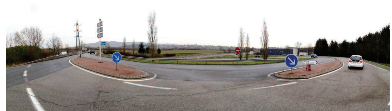
Photo 49 : S1-14 - L'échangeur RN7/RN489/RD307. Source : © Egis Environnement / O. GAUDIN, 2013.
