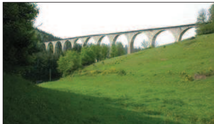
Photo 4 : Le viaduc de Pont Marteau, à Sainte-Colombe-sur-Gand
