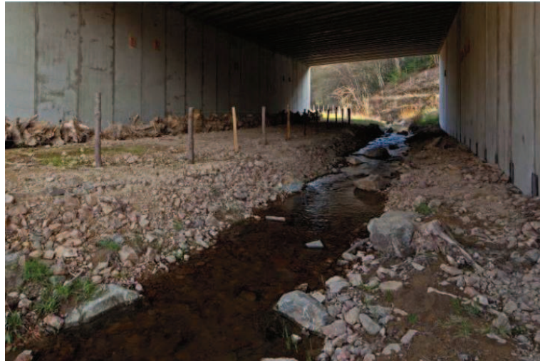
Photo 3 : Exemple d'ouvrage hydraulique de rétablissement de cours d'eau et de passage à faune sur l'A89
