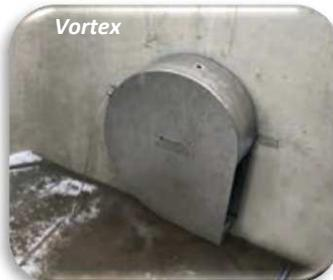
*Système de cloison avec orifice*
