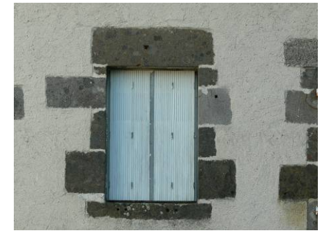
Enduit couvrant laissant apparaître le décor en pierre de taille
