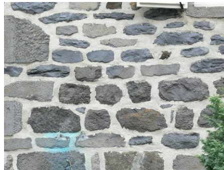
Moellons irréguliers destinés à être enduits
