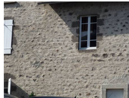
Rejointement à fleur de moellons et badigeon
