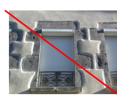
Rejointement à fleur de moellons et badigeon
