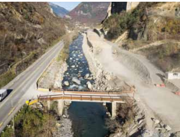
Le pont carrier avant sa déconstruction en avril 2016
