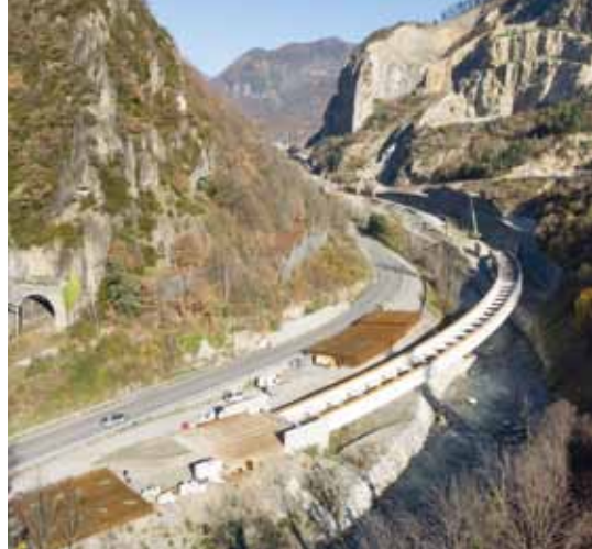
Le viaduc aval, côté Moûtiers, avant l'étape de coffrage/ferraillage/bétonnage du tablier
