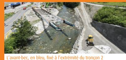
L'avant-bec, en bleu, fixé à l'extrémité du tronçon 2
