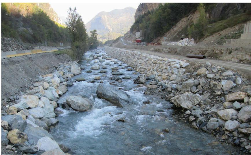
Les caches à poissons aménagées dans le lit de l'Isère grâce à des blocs rocheux
