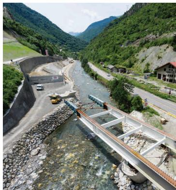
Préparation du lançage du tablier du viaduc amont
