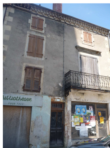
Bâtiment à l'abandon- Place de l'Eglise
