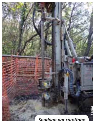
Sondage par carottage
