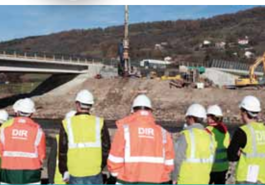
Visite du Groupe Technique Environnement sur le chantier du pont sur la Loire
