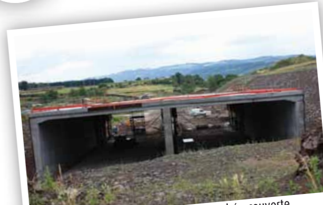
Un premier tronçon du cadre de la tranchée couverte est terminé. Les remblais sont en cours.
