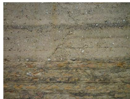
Parement en béton banché et parement traditionnel
