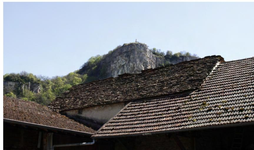
*Couverture traditionnelle en lauzes et couvertures plus récentes en tuiles mécaniques*
