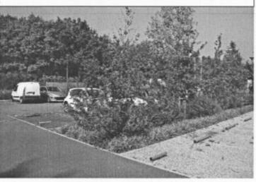
voirie en enrobé et d'un trottoir en sablé réservé aux piétons. Conformément aux préconisations de l'étude sol, les noues permettront de retenir l'eau de ruissellement de la voirie avant son évacuation dans le réseau communale. Le profil de voie en enrobé a été réduit à une largeur minimale afin de limiter la surface d'imperméabilisation des sols. Les trottoirs sont traités en sablé de pays.
