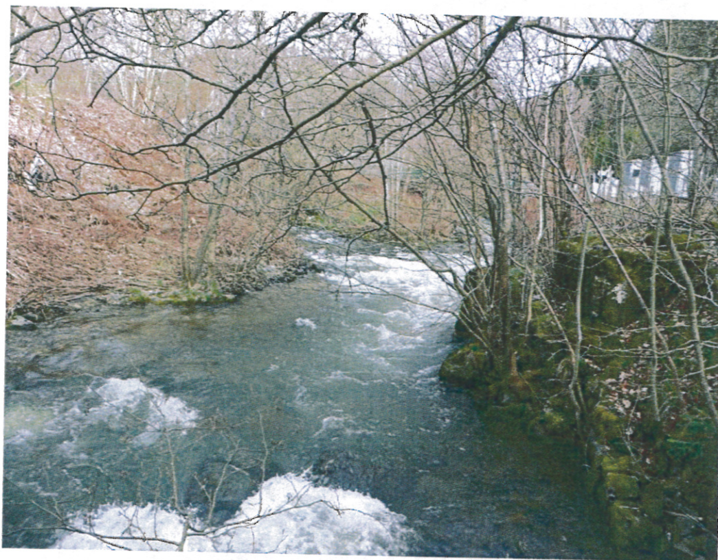
Figure 7 : Appuis en rive gauche de l'ancienne prise d'eau
