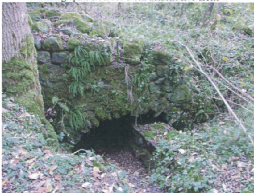
Photographie 4 : salle voutée des turbines du moulin.
