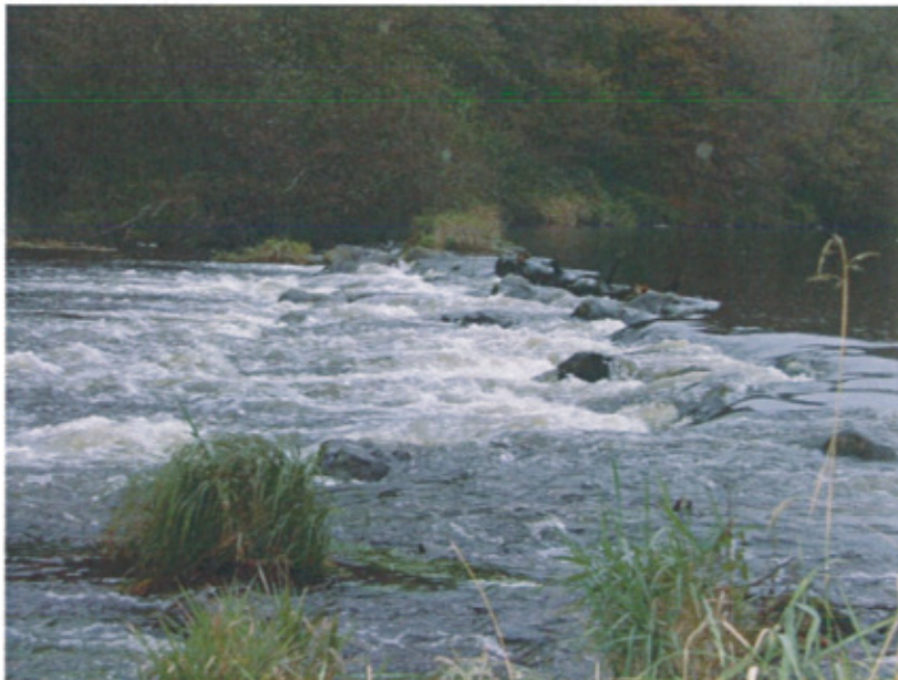
Photographie 3 : levée d'eau actuelle rive droite
