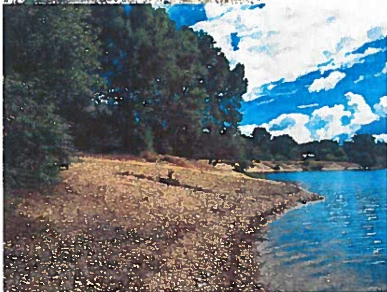
Bord du lac avec création d'une rampe sous l'eau en béton préfabriqué sur 13ml de long
