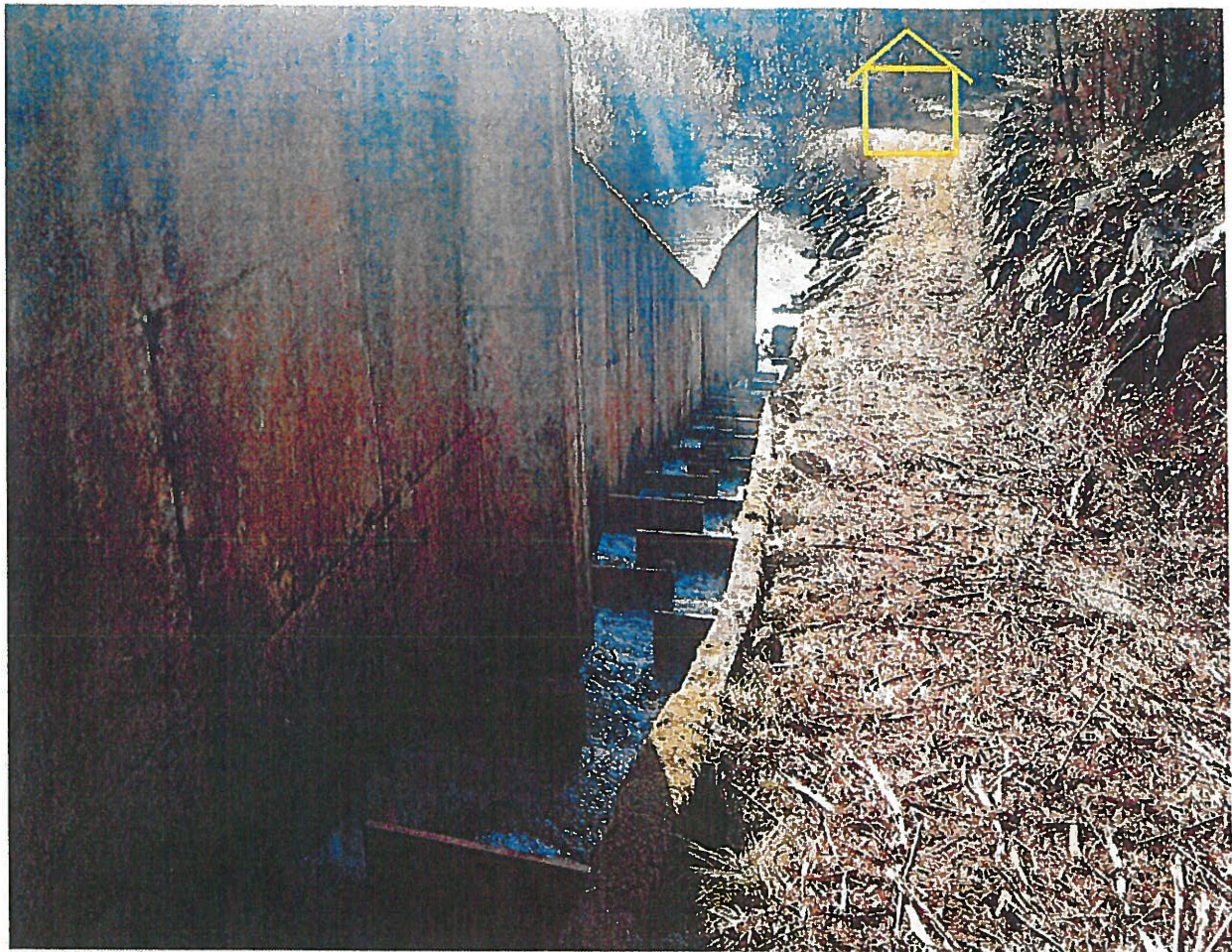
Photographie n°1 : Vue aval vers l'emplacement prévisionnel du bâtiment de production – Aout 2016
