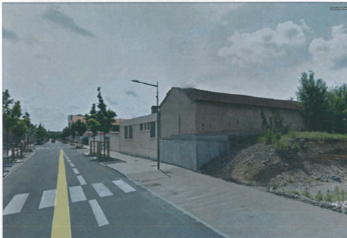
Vue 2 : depuis avenue de l'Europe vers la future voie pompiers
