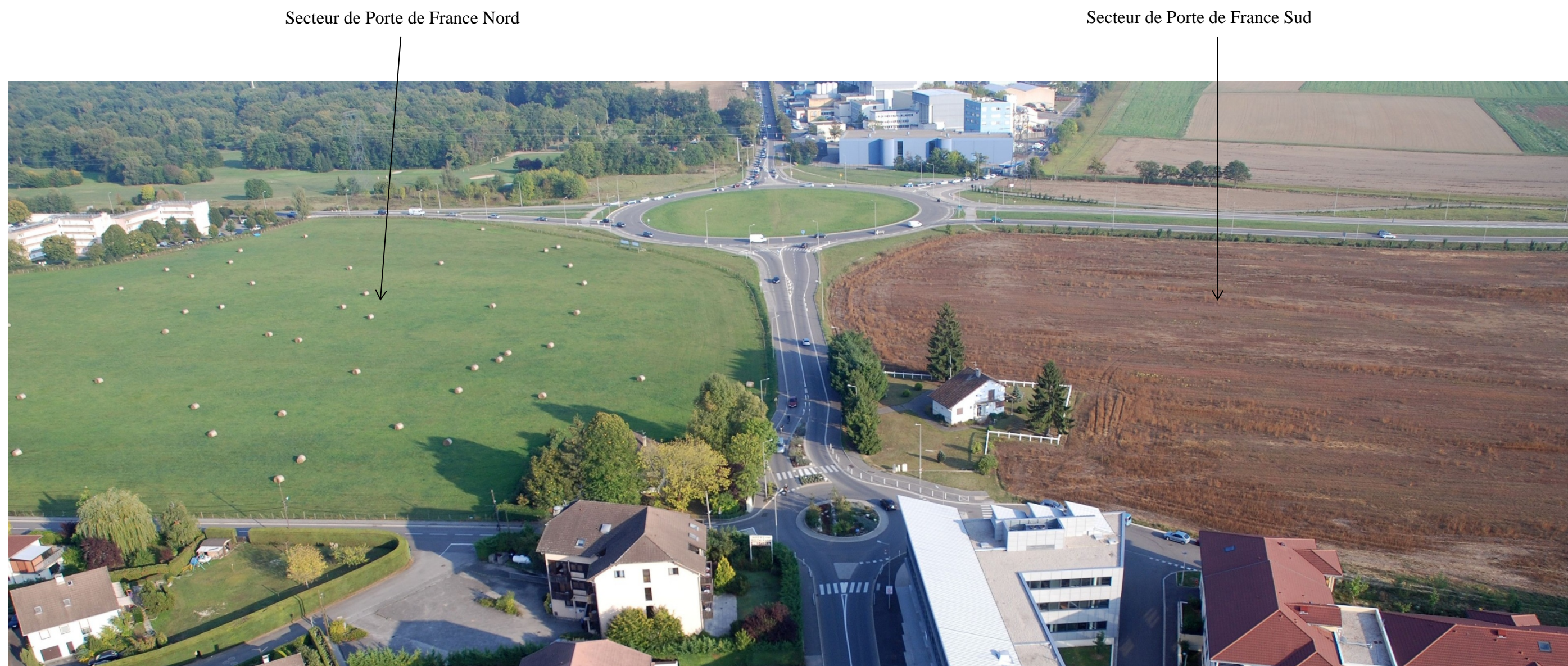
Vue aérienne du secteur de Porte de France (prise de vue réalisée par l'Agence COM'AIR datant du 29 septembre 2011- crédit photo mairie de Saint-Genis-Pouilly)
