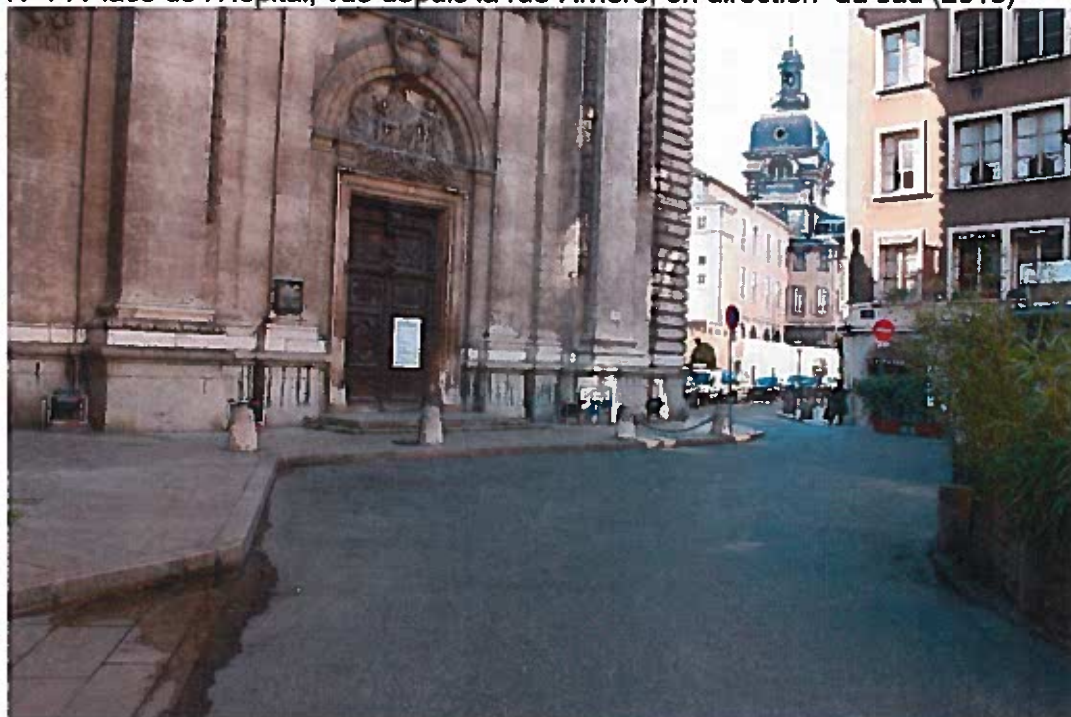
N°4 : Place de l'Hôpital, vue depuis la rue Rivière, en direction du sud (2013)
