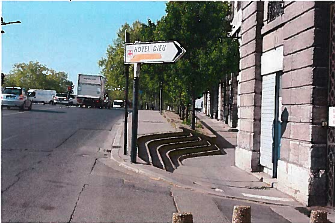
N°7 : trottoir du quai Jules Courmont , vue en direction du sud (2013)
