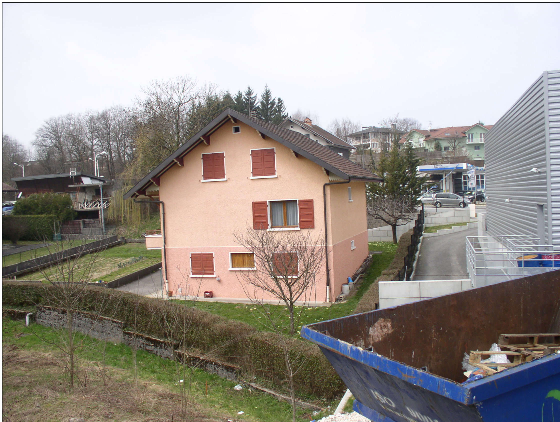
2 : Limite Nord-est du site (limite avec le garage NISSAN)
