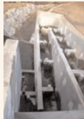
Création d'une passe à poissons
