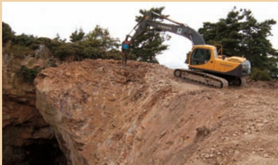
Mise en sécurité de l'effondrement minier de Barlet
