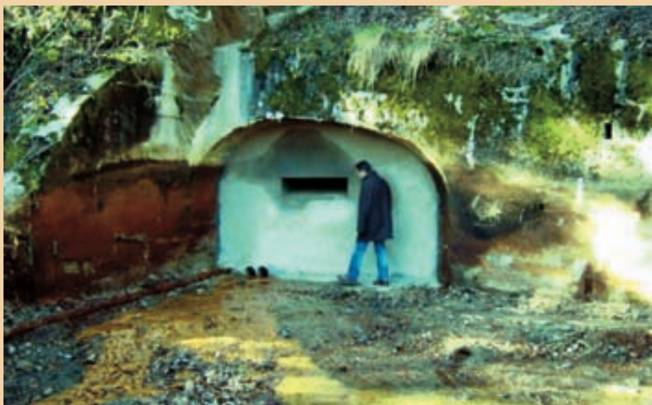
Fermeture d'une galerie avec passage pour chiroptères
