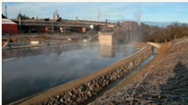
Restauration du lit du cours d'eau et enrochement
