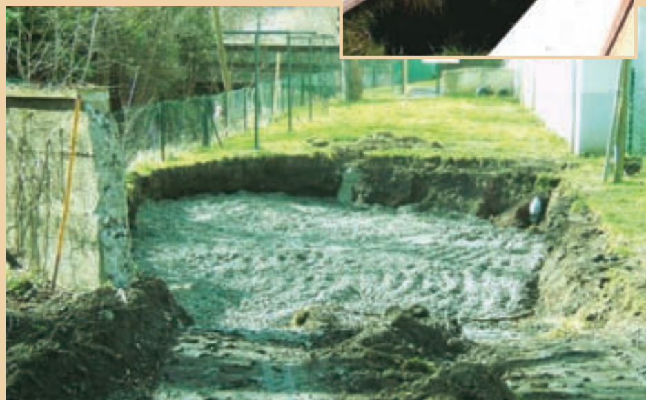
mars 2008 : l'orifice après mise en place du béton
