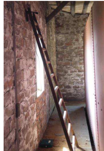
Dispositif d'enregistrement automatique des chiroptères dans les combles du château d'eau O. Montavon, Écosphère
